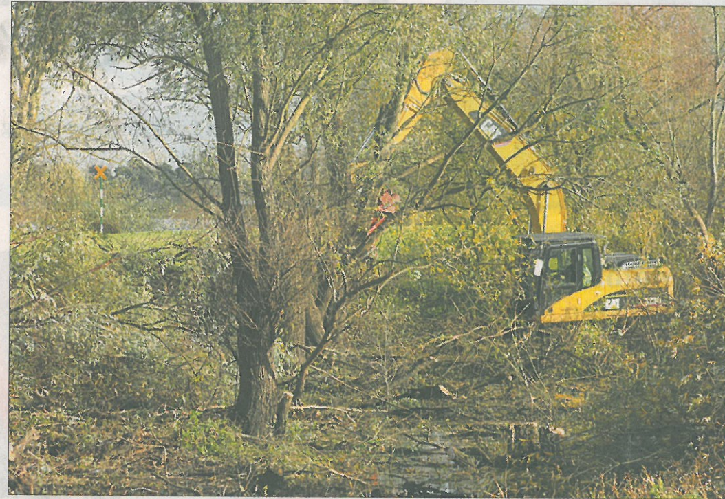
Mit einem Bagger, der Gehölze abkneift und aus dem Uferbereich der Elbe entfernt, hat das Unternehmen Hof Steinberg in den vergangenen Wochen den präzise geplanten Rückschnitt im Biosphärenreservat in Lüchow-Dannenberg vorgenommen.
